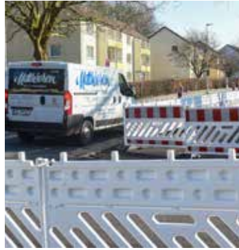
Baustellen-Alltag in Weiche
