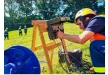
Fernmeldeleitungen werden aufgebaut
